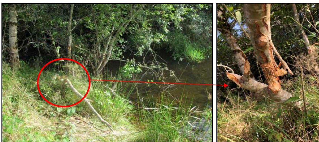
Photo 50 : Arbres rongés au droit de la brèche dans le canal d'aménée (Source : UJ, BE-JC, 28/09/2021)
